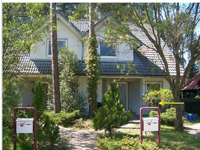
Eingang (Haus A)
